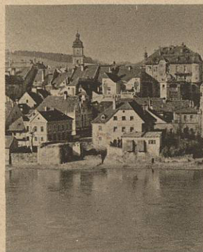
Marburg an der Drau (Steiermark) Linkes Draaufer — altes Brückentor
